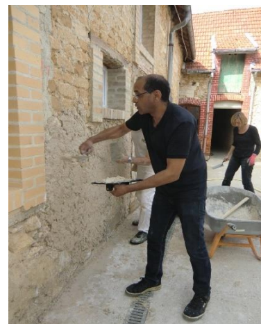
Stage enduits à la chaux (Source : PNR MR, 2015)
