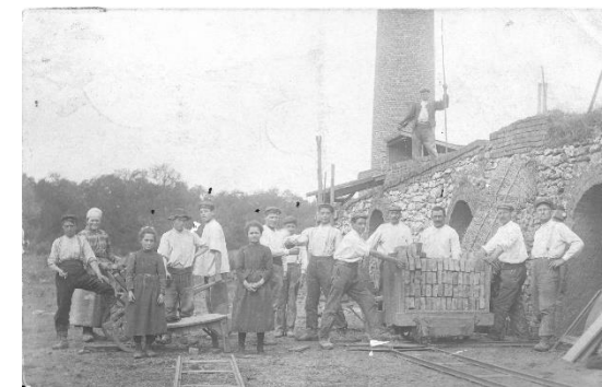
Briqueterie de Saint-Imoges
