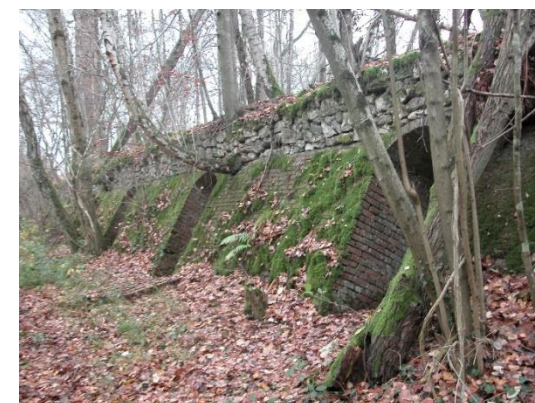
Briqueterie du Vertin (Source : PNR MR)
