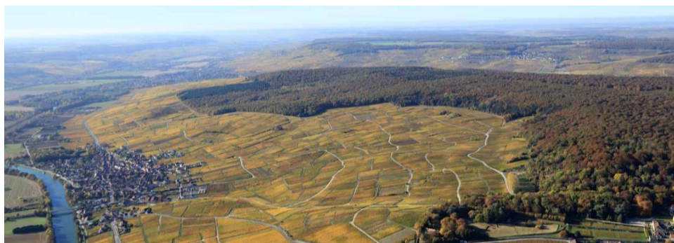
Localisation du village de Cumières en bas de versant dans la vallée de la Marne (Source : PNR MR)
